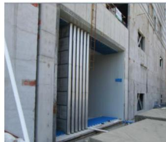
图 4 M701F 燃气轮机进气道消音器外形图
